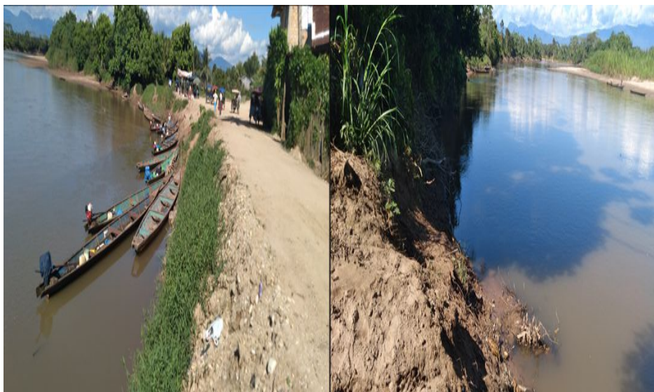
FOTOGRAFIA N°02: SE VISUALIZA LA EROSIÓN DEL BORDO DEL RIO QUE AFECTA DIRECTAMENTE A CARRETERA.
